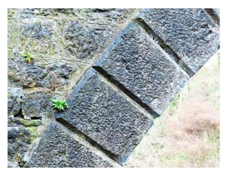
Figure 223 Detail of voussoirs on arch ring
